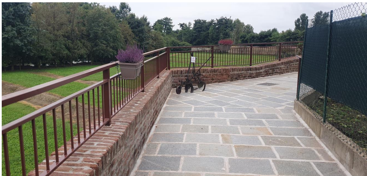
Scorcio della ristrutturazione dello storico muraglione di Asigliano Vercellese.
